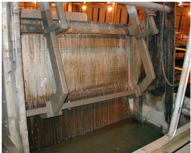
Kuva 2: Esimerkki välpästä.
